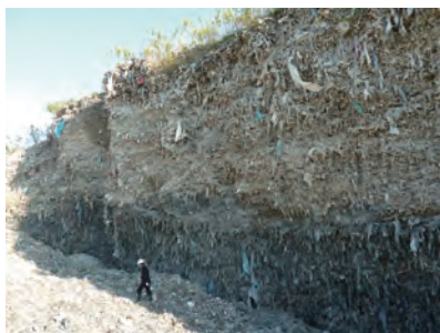
Fig. 2 Illegal dumping site subject to slope failure crisis (Japan) 斜面崩壊の危険がある日本国内の不法投棄現場
